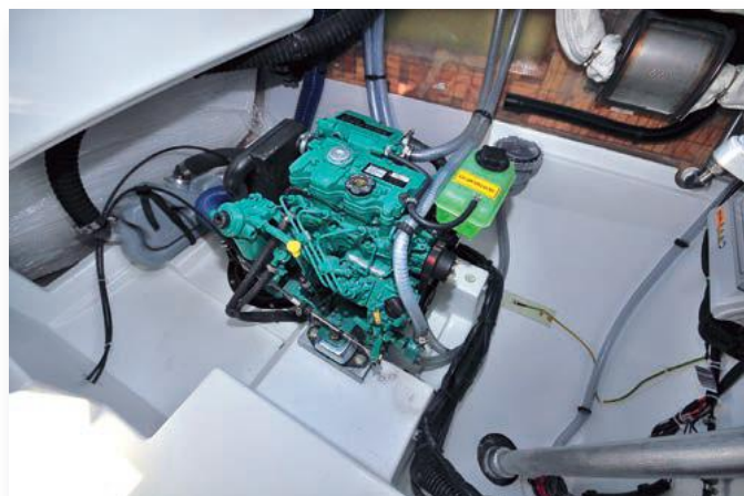
→ Une cale moteur qui laisse de la place pour les interventions, notez le bon compactage du sandwich balsa/verre. Une trappe ferme l'arrière du compartiment, mais une mousse dense serait préférable au polystyrène d'insubmersibilité.
